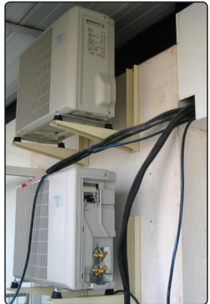
**Figura 6.** El aire acondicionado siempre debe instalarse cerca del techo.
