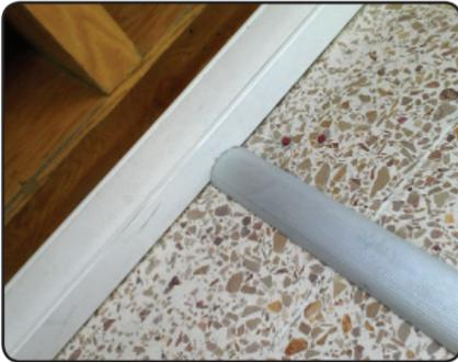
**Figura 7.** El canal de media luna evita problemas de maltrato de los cables tendidos obre el piso.
