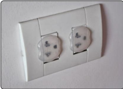
**Figura 9.** Los protectores de tomacorrientes evitan problemas de funcionamiento por suciedad.
