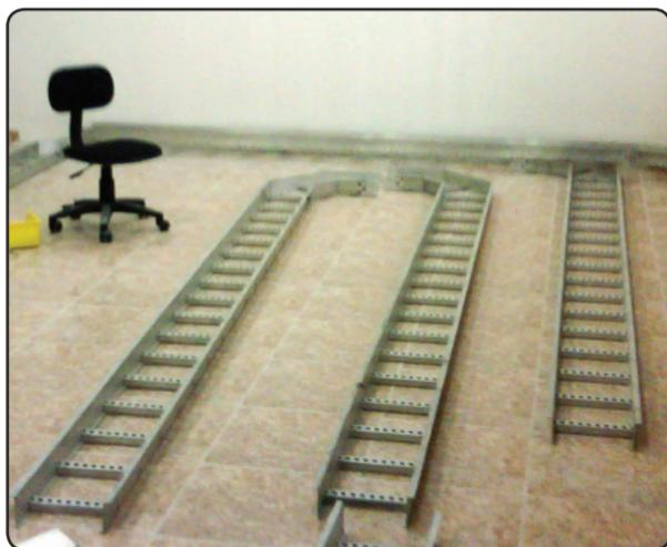
**Figura 3.** Los rieles en forma de escalera permiten el transporte seguro del cableado de la red.
