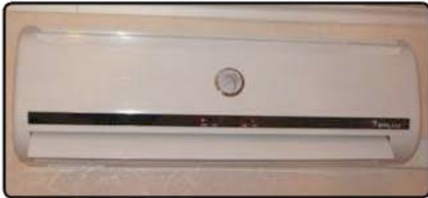
Figura 6. Los sistemas de acondicionamiento de aire deben ser calculados en función del volumen de la habitación, en metros cúbicos.
