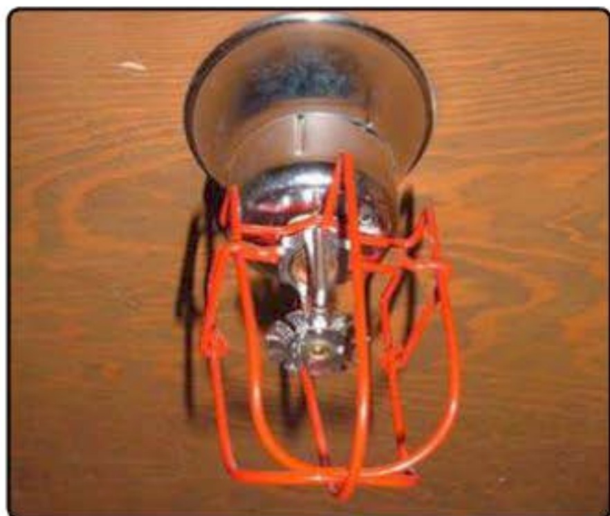
Figura 10. Un sprinkler es un dispositivo para extinción de incendios que libera agua sobre la zona afectada.
