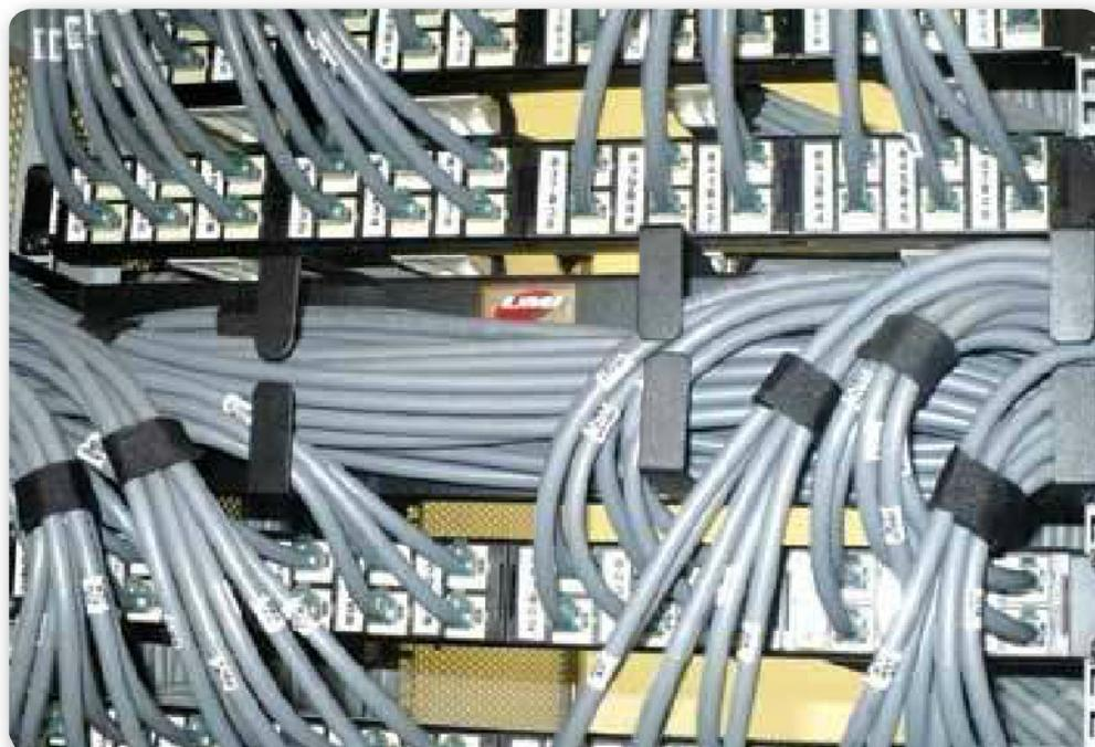
**Figura 16.** La **planificación** adecuada de una implementación de red nos asegura que no tendremos un rack desordenado.
