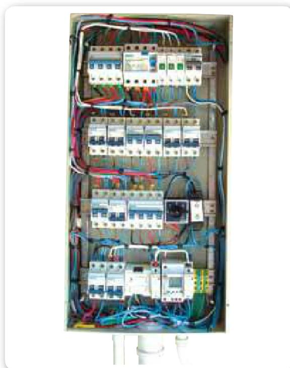
**Figura 25.** En esta imagen vemos un tablero eléctrico ordenado correctamente, con sus cables precintados.
