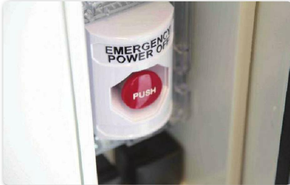
**Figura 25.** Emergency Power Off, o EPO, nos permite un rápido apagado frente a emergencias.
