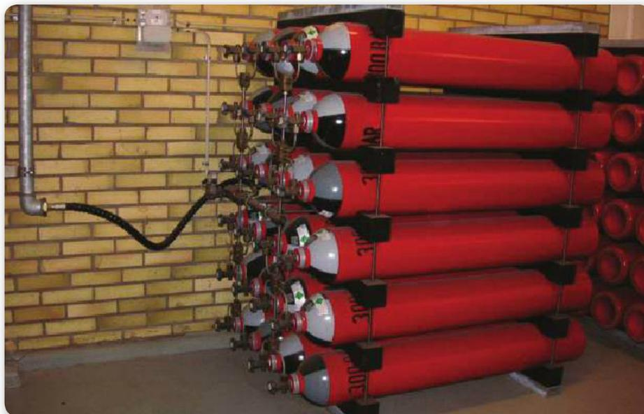
**Figura 22.** Tubos de **gas Inergen** para extinción de incendios en data centers. No daña los equipos ni afecta a las personas.
