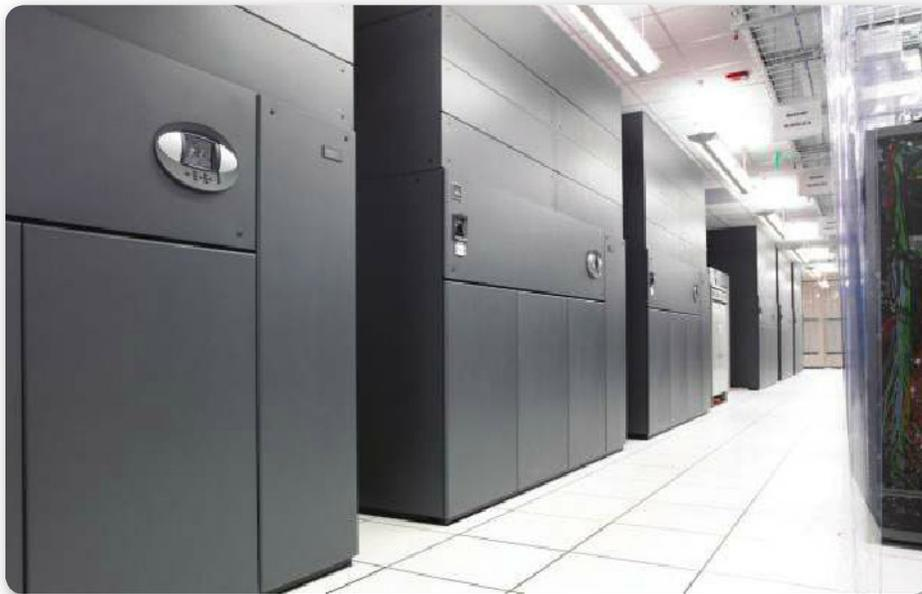
**Figura 23.** Los HVAC para data centers succionan el aire caliente por el techo, lo enfrían y lo envían por debajo del piso técnico.
