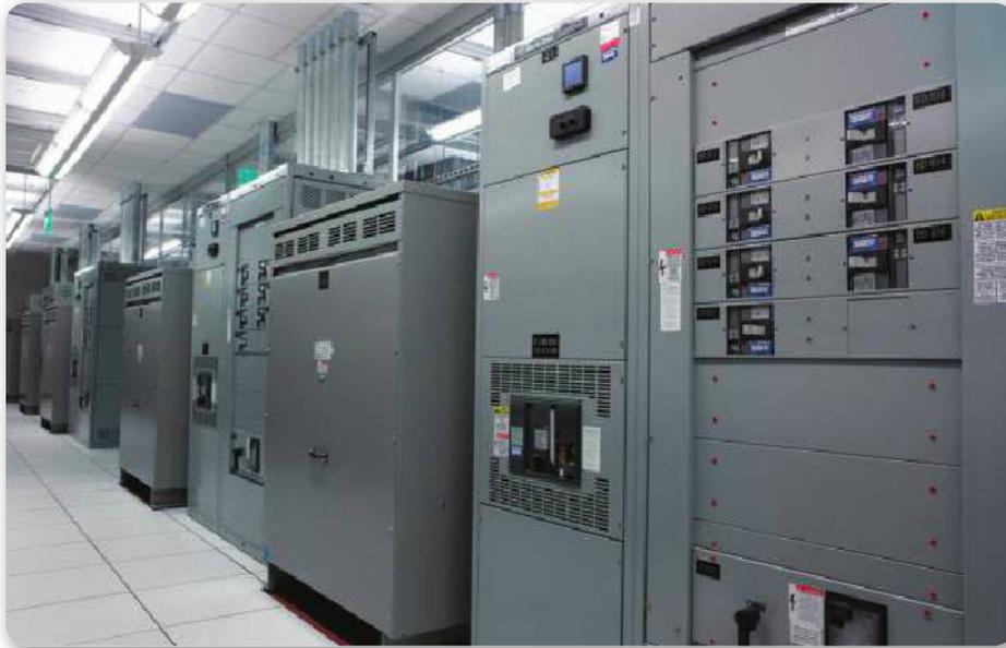
**Figura 24. General Electric Spectra Series Power Panel** otorga protección eléctrica y permite intercambiar las líneas.
