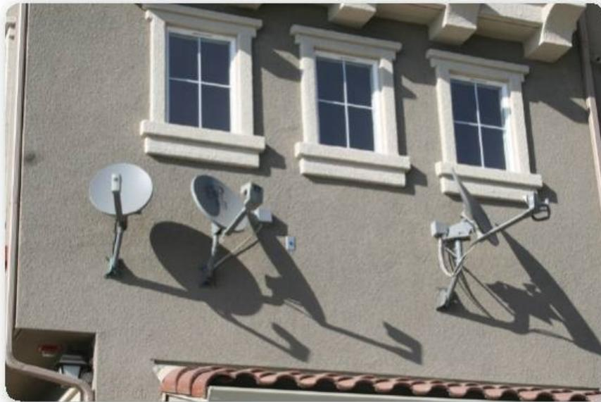
**Figura 11.** Antenas de 60 cm de diámetro características en sistemas de **televisión directa al hogar**. Permiten la recepción satelital de transmisiones de TV digital tanto en definición estándar como en HD, además de señales con calidad digital de audio.
