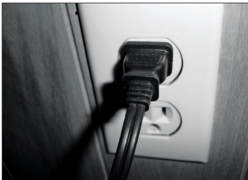
Figura 9. El equipo necesario para esta producción no consume la energía suficiente como para justificar el alquiler o la compra de un generador de energía. Con el suministro eléctrico del lugar nos alcanzará.
