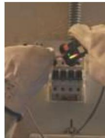
5. Verificar leds del concentrador, llamada al CGO y anotación datos
