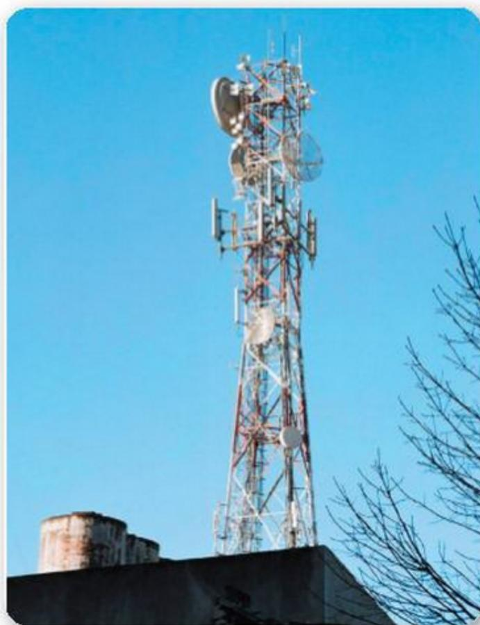
**Figura 15.** Los arreglos de antenas telefónicas se caracterizan por ser bidireccionales (emisión y recepción) de baja potencia.
